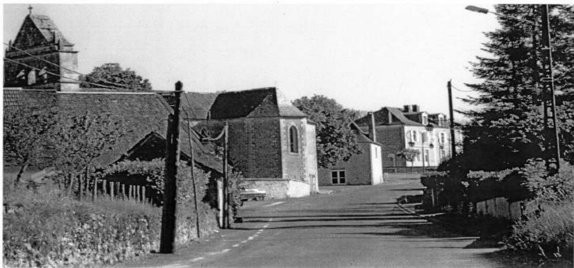
La Grande Rue avant les travaux d'aménagement
